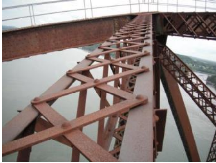
Acier original de 1917 (97 ans) situé hors de la zone d'éclaboussure
